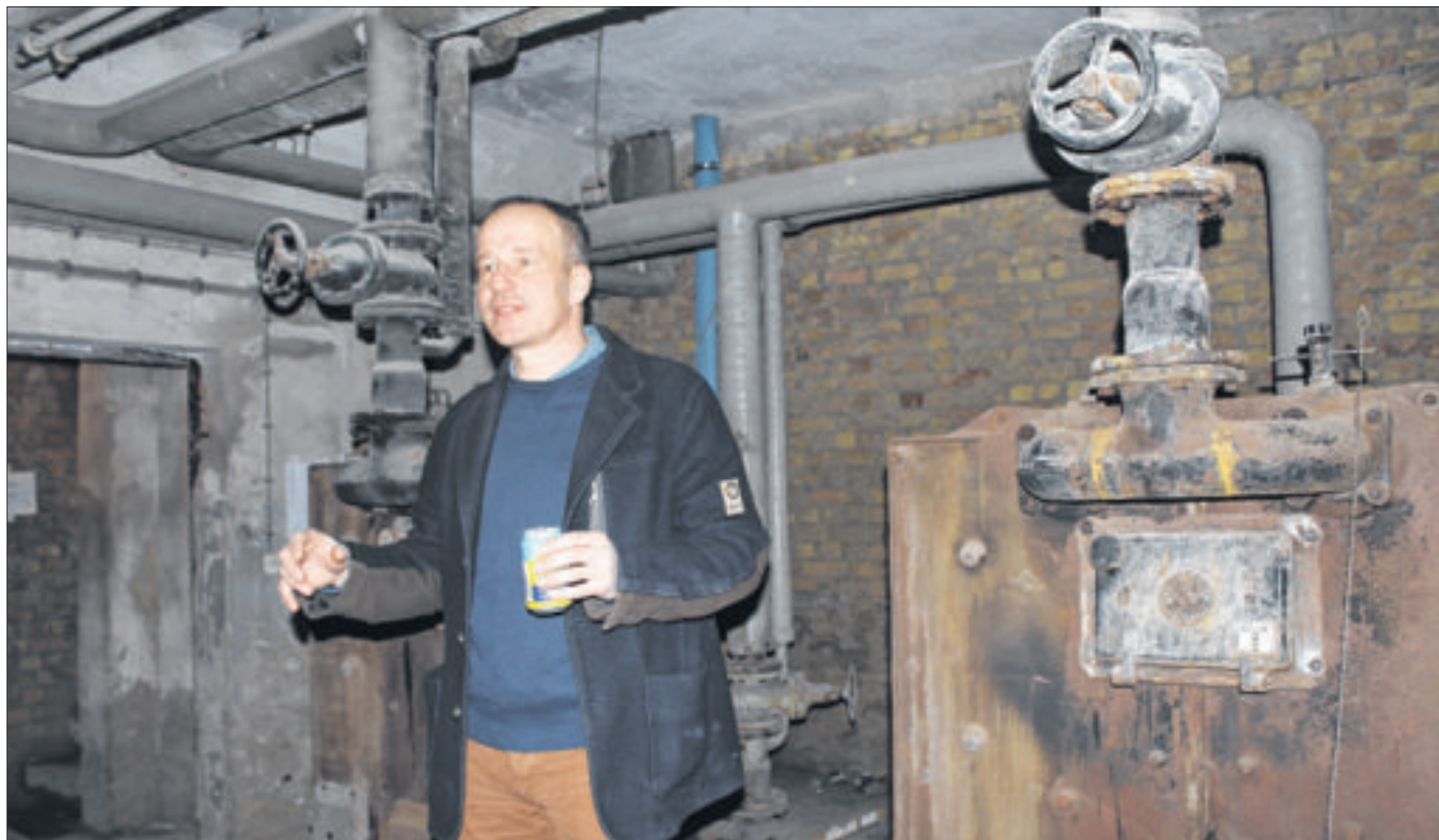
Sebastian Jacobs von der Bauherrengemeinschaft in der künftigen Kesselbar im Keller der historischen Post. Die Türen der alten Heizkessel wurden stehengelassen, um sie später als Dekoration für den Ausschankbereich zu verwenden.
