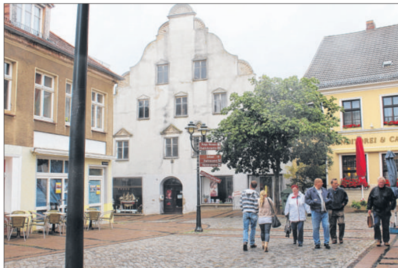
Umbau und Sanierung des früheren Gardinenhauses (Bildmitte) sollen voraussichtlich im nächsten Jahr beginnen.
