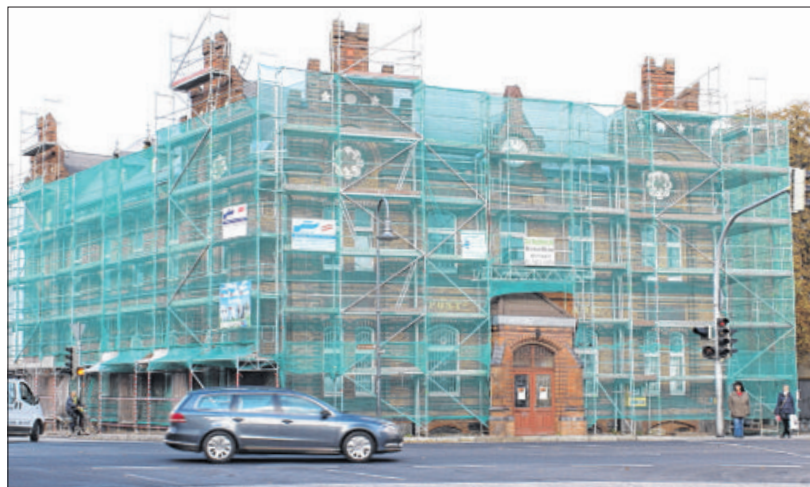
Noch in diesem Jahr soll das Baugerüst wieder verschwinden. Es wird für Arbeiten am Dach und an den Fenstern benötigt.
